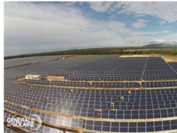
Centrale de Belvezet, Gard
