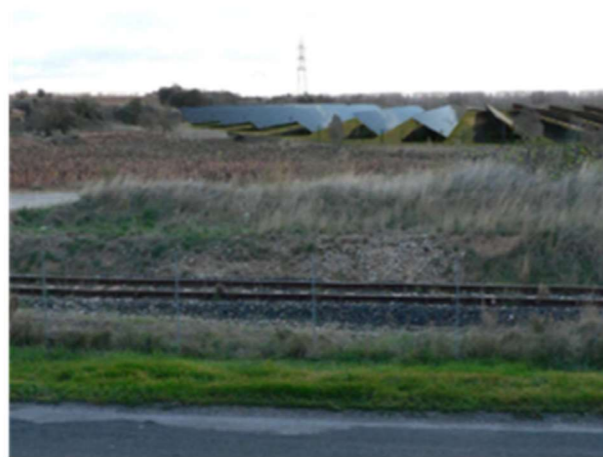
Centrale de Narbonne, Aude
