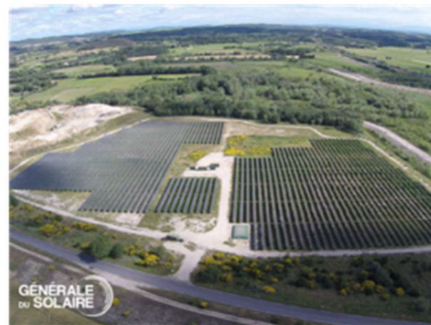
Centrale de Pujot, Gard
