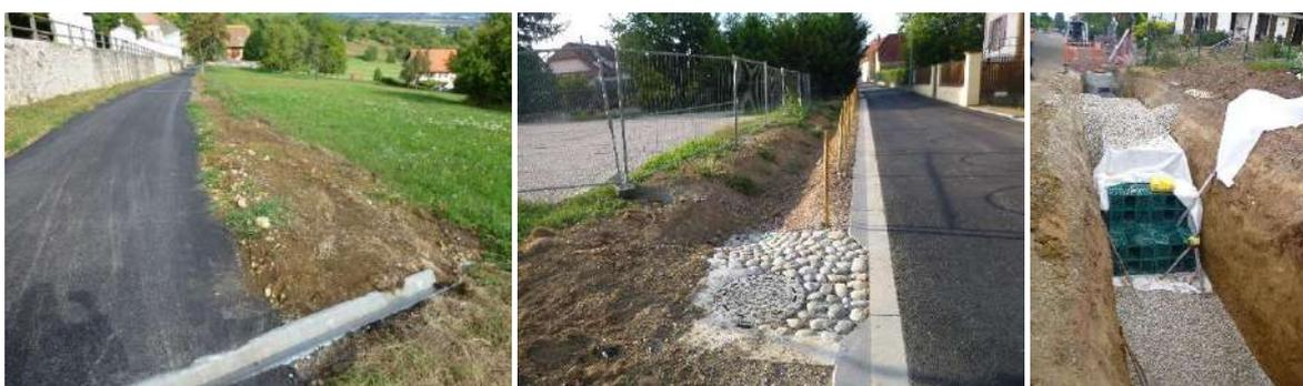
**Pose de traverses et création d'une noue pour limiter le ruissellement des eaux pluviales et la surcharge du réseau d'assainissement collectif**
